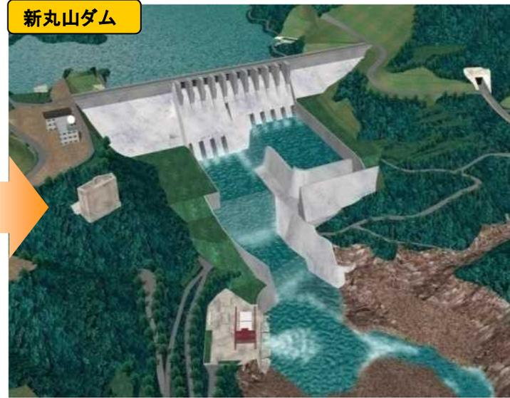
既設の丸山ダムの下流に新丸山ダムを新設(かさ上げ)し、貯水容量を増加させることにより、治水・利水(流水の正常な機能の維持・発電)機能の増強を図る。
