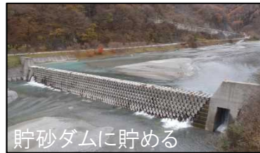
堆砂対策の例 (貯砂ダム)
